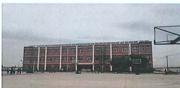
5.沙坡头区公共建筑采暖图片
