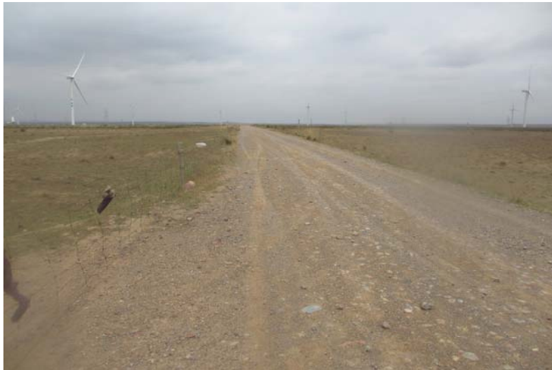
图 6-6 风电场内检修道路（同类项目）
