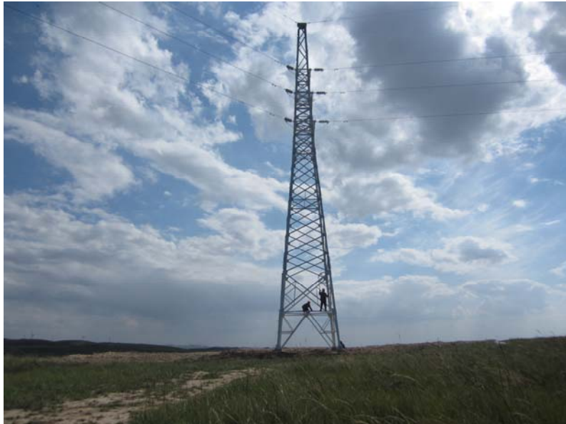
图 6-7 35kV 集电线路（同类项目）
