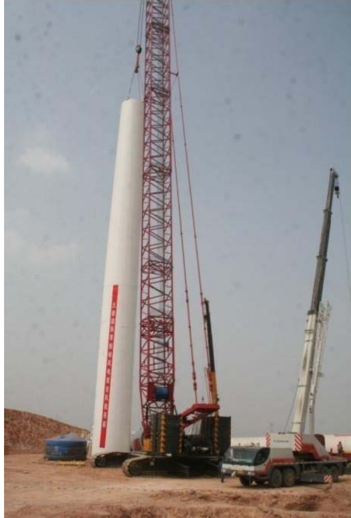
图 6-4 塔筒吊装施工图（同类项目）
