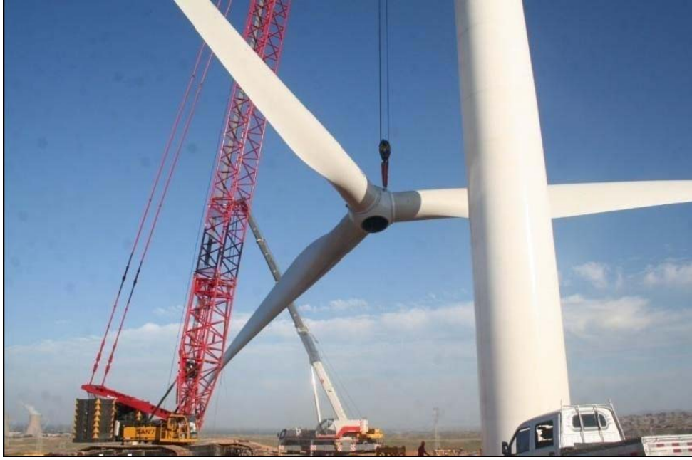
图 6-5 叶片吊装施工图（同类项目）
