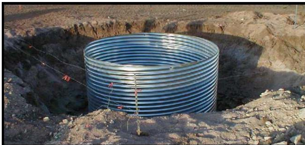
图6-3 P&H无张力灌注桩基础
