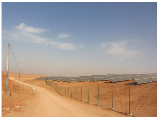
项目光伏阵列区及进场道路
