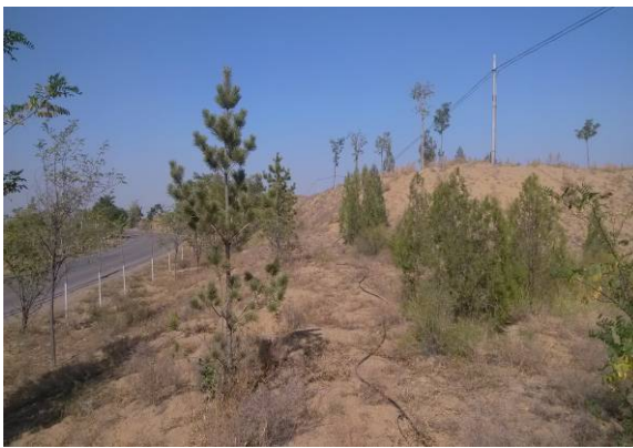
原有公路边坡防护
