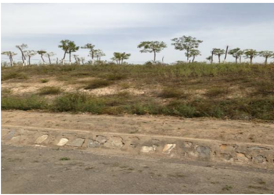
邻近公路边坡防护
