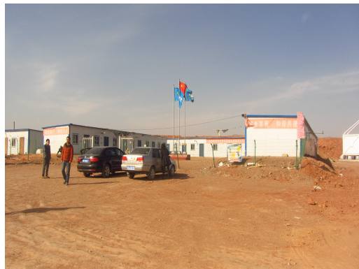
项目临时施工营地
