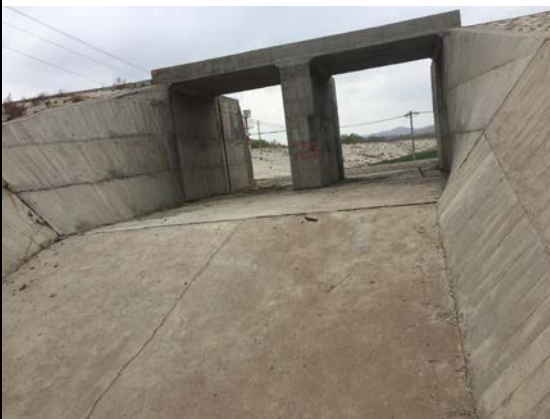
二府营水库小桥现状
