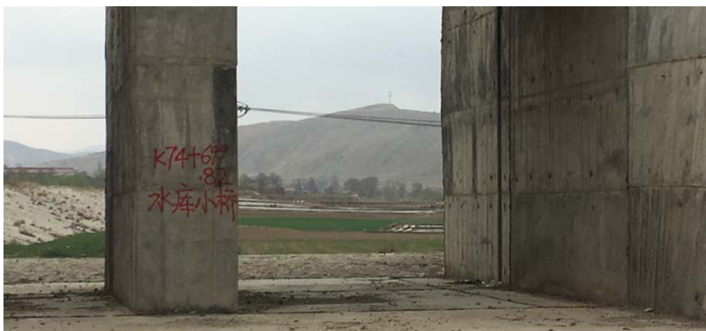
二府营水库现状
