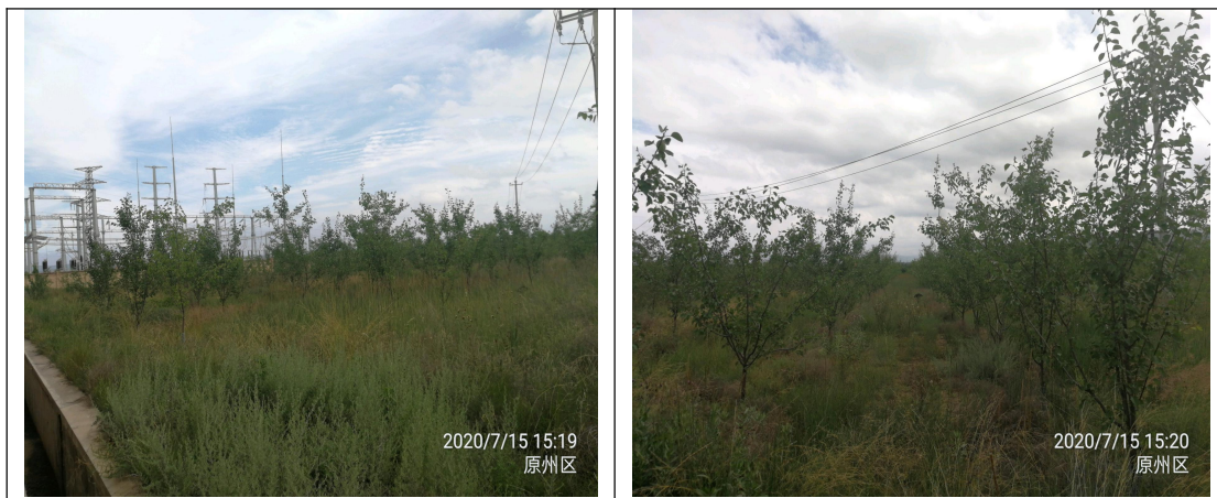
图 3.1-2 清水河 330kV 变电站本期扩建场地现状图
