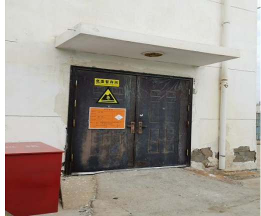
升压站内危废暂存间
