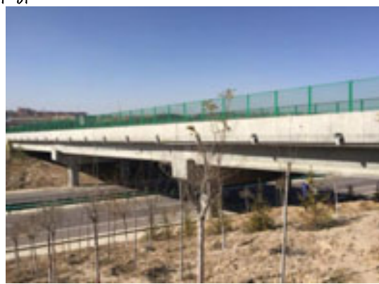
尹家山分离立交桥
