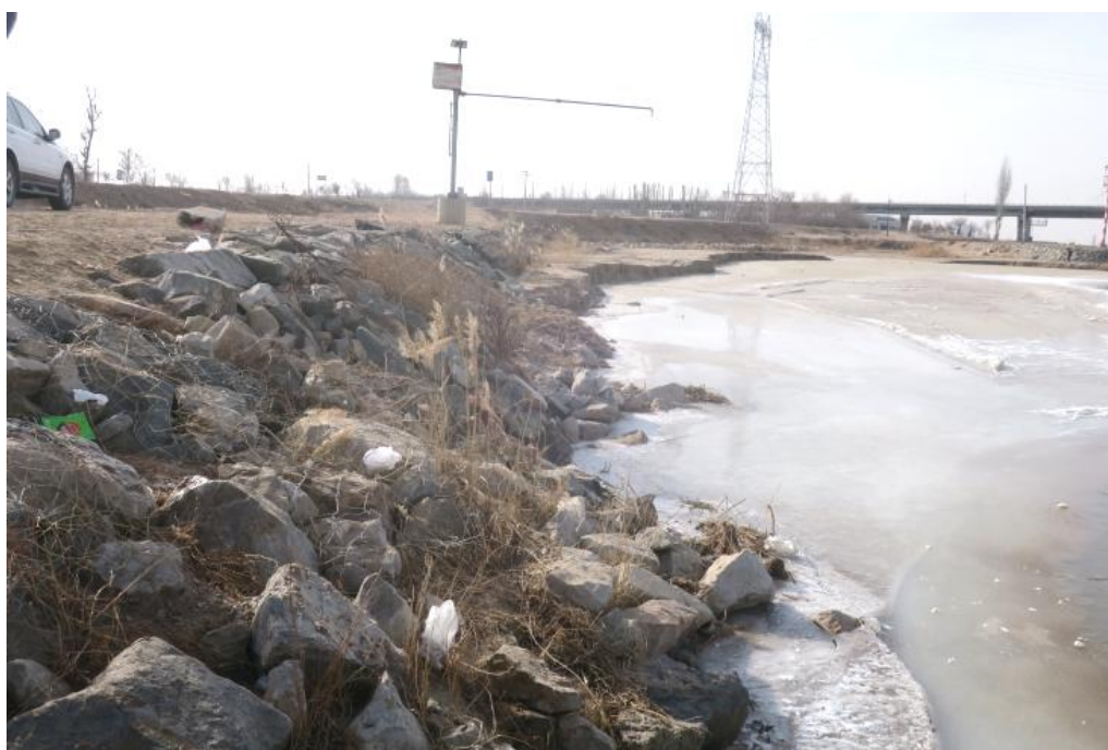
图 2.5-6 需补抛根石，重做护坡坝垛典型图片
