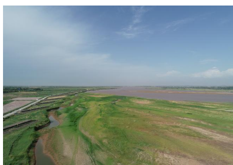
典型工程 3：邵家桥控导工程
