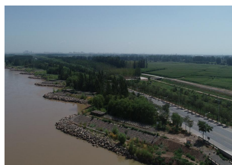
典型工程 4：吴忠左岸防护工程
