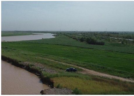
典型工程 7：柳条滩生态修复工程
