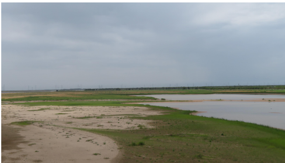
图4.12-6 京星农场控导工程背水侧照片2
