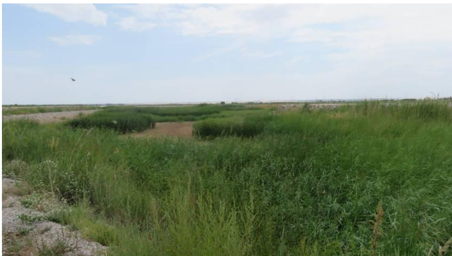
图4.12-5 京星农场控导工程背水侧照片1
