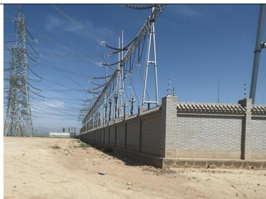
沙湖变西南侧围墙处
