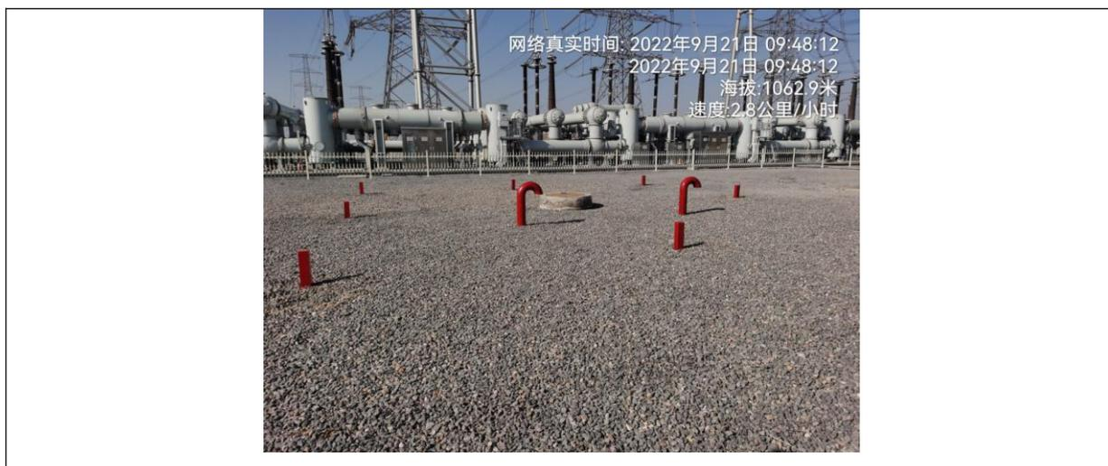
图 6.5-1 沙湖变电站前期已建事故油池（79m<sup>3</sup>）
