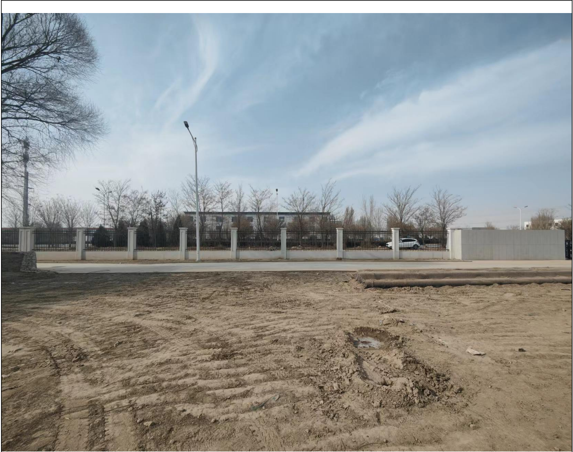
图 1-7 拟建检测室西侧实景
