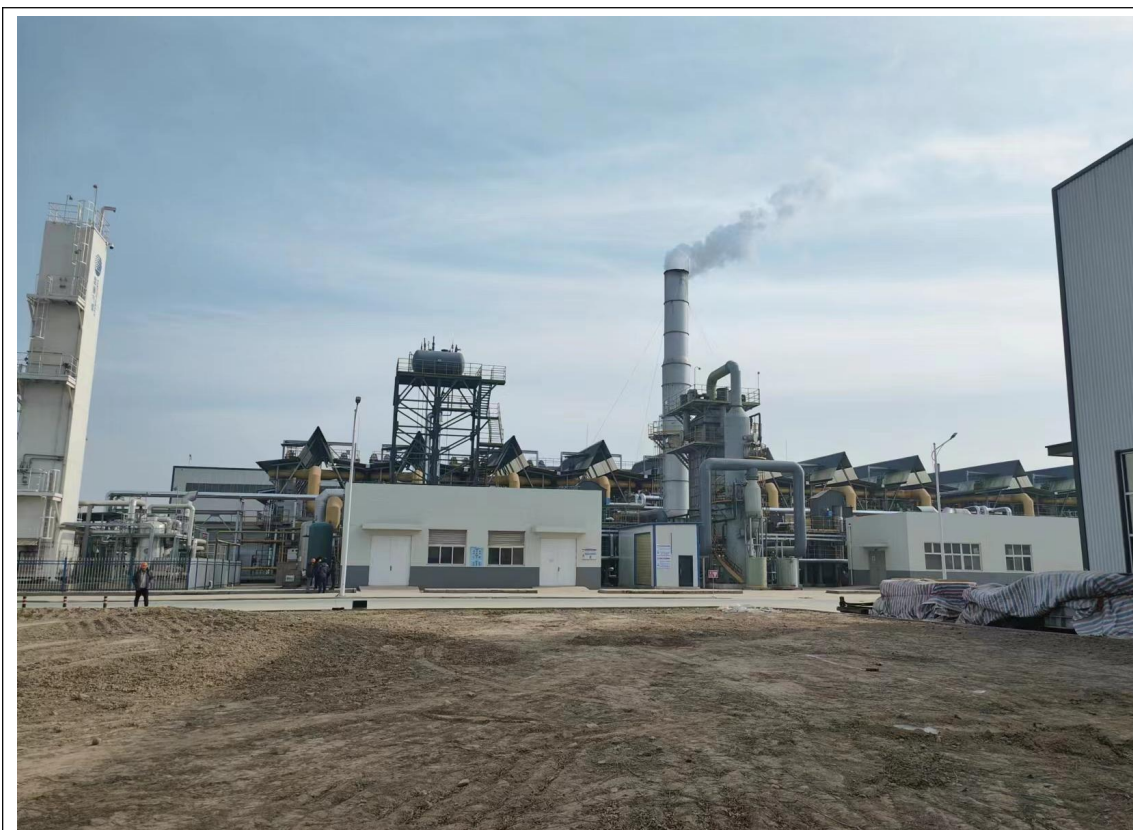
图 1-5 拟建检测室东侧实景
