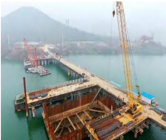
涉水桥梁钢围堰施工
