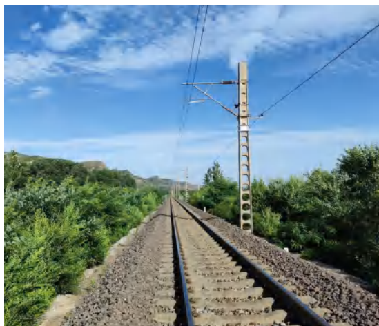
既有线路基工程
