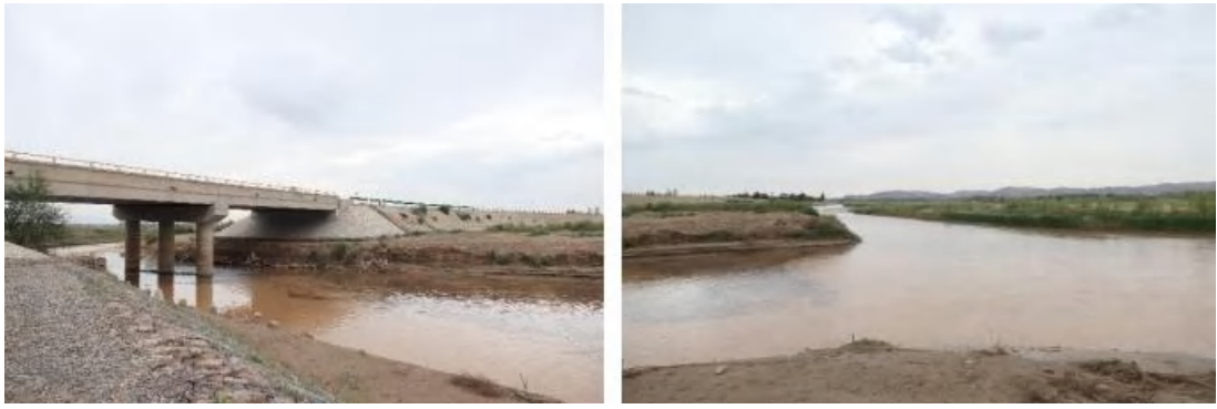
图5.2-23 清水河汇口断面现状
