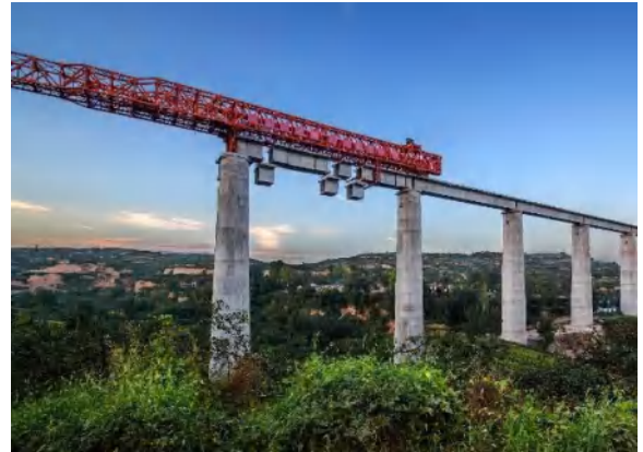
节段拼装施工方法
