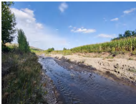
乃家河特大桥桥址
