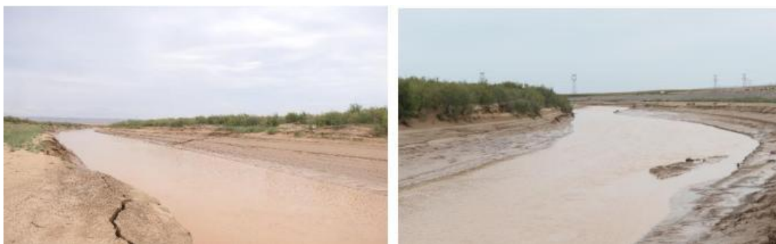
图5.2-25 大沙梁断面现状
