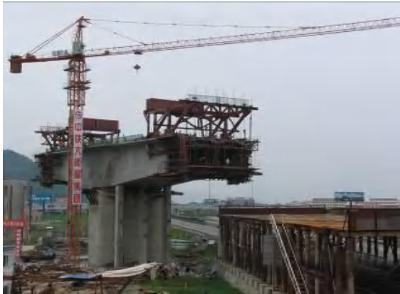
悬臂浇筑施工方法
