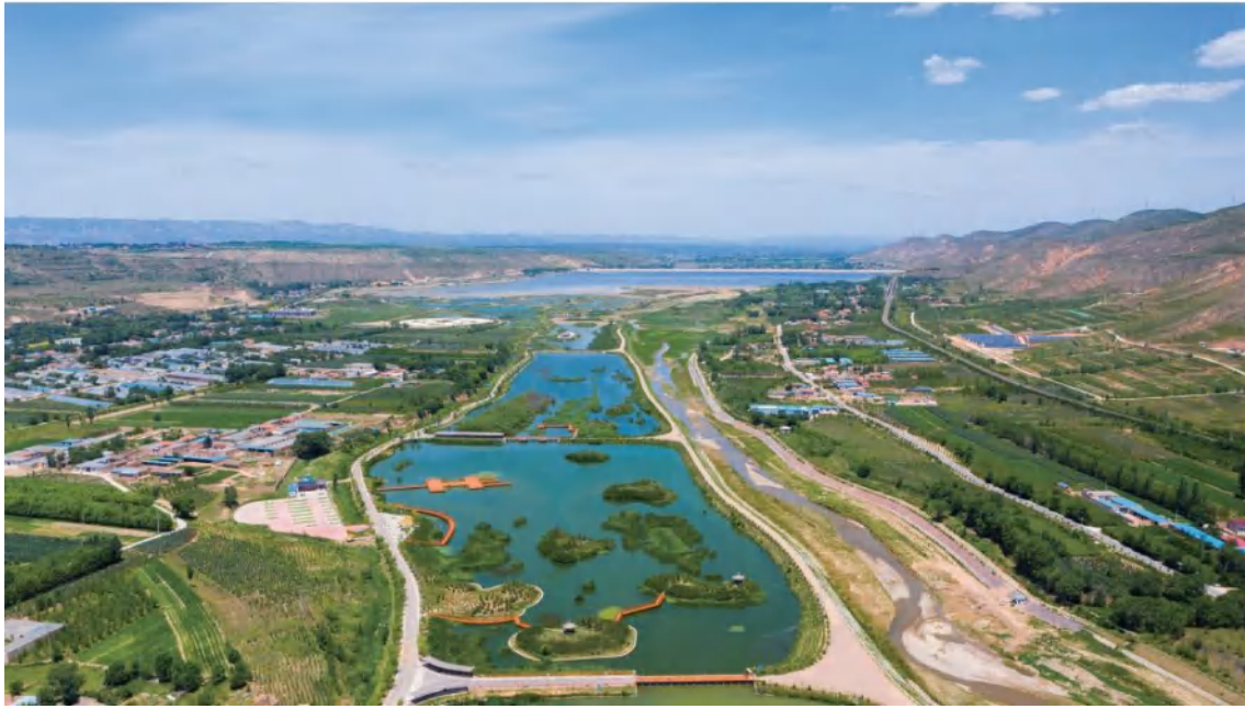
图5.2-8 湿地生态系统现场照片
