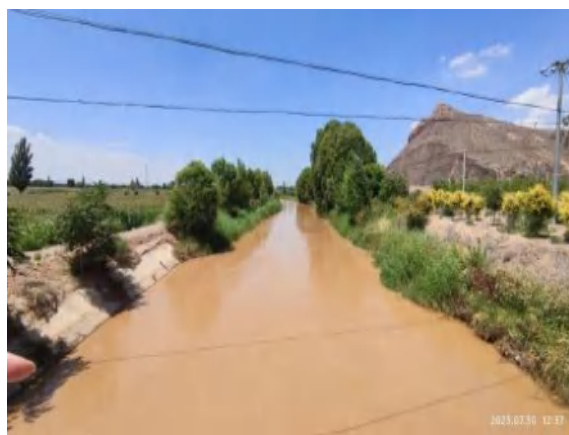
上行联络线跨包兰铁路特大桥桥址
