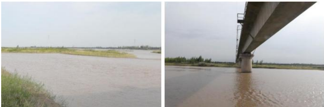
图5.2-22 铁路桥下断面现状
