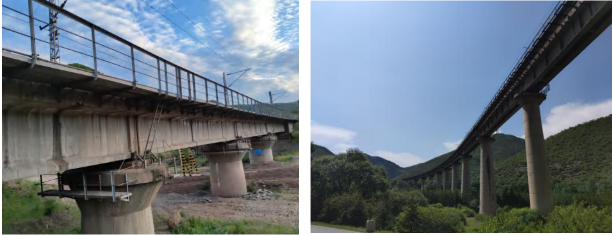
既有颍河大桥现状
