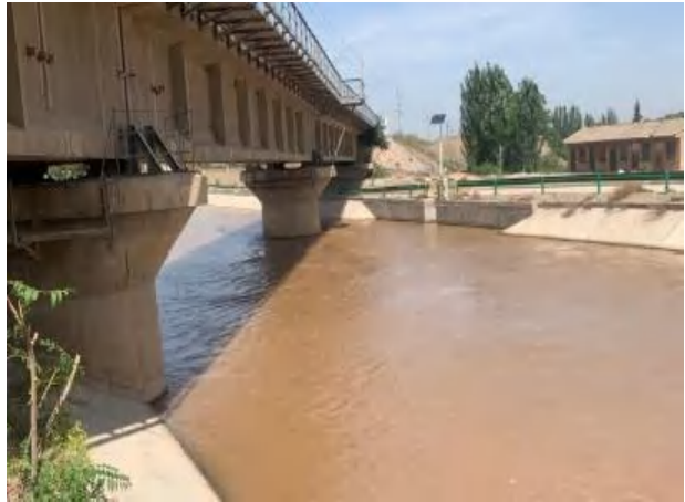
跨七星渠特大桥桥址
