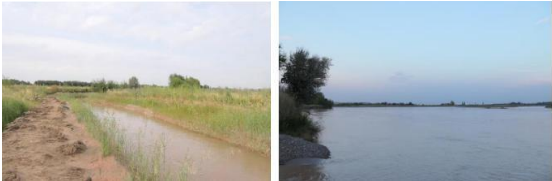
图5.2-21 铁路桥上游4公里断面现状
