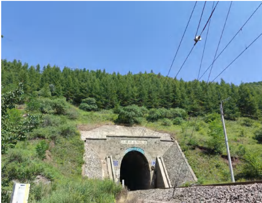
既有三关口隧道
