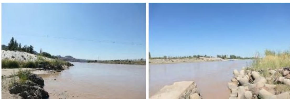
图5.2-19 沙坡头坝下断面现状
