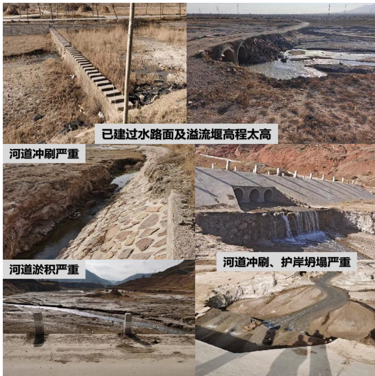
图 2.1-8 冬至河已建砌护、基础河槽及已建基础设施现状图
