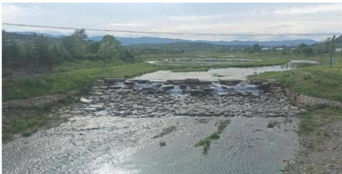
图 2.4-6 新建生态溢流堰实景示意图
