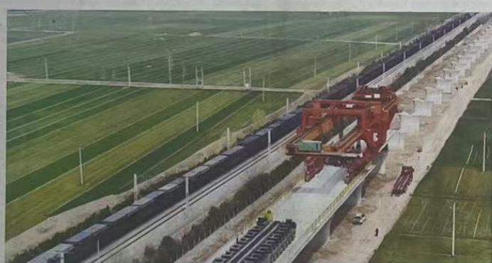
3月13日，在雄鸡高铁山东聊城站建设现场，中铁十局的工作人员正在进行架梁作业（无人机照片）。图中，国家重点工程（鲁）济（京）高铁山东聊城至梁山段正进行架梁施工，稳步推进架梁施工。图中，雄鸡高铁是我国高速铁路网“八纵八横”之京涛（台）通道的重要组成部分，设计时速350公里。
