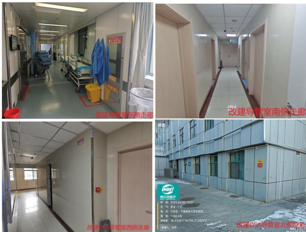
图 1-6 拟改建 DSA 导管室及周围现状照片
