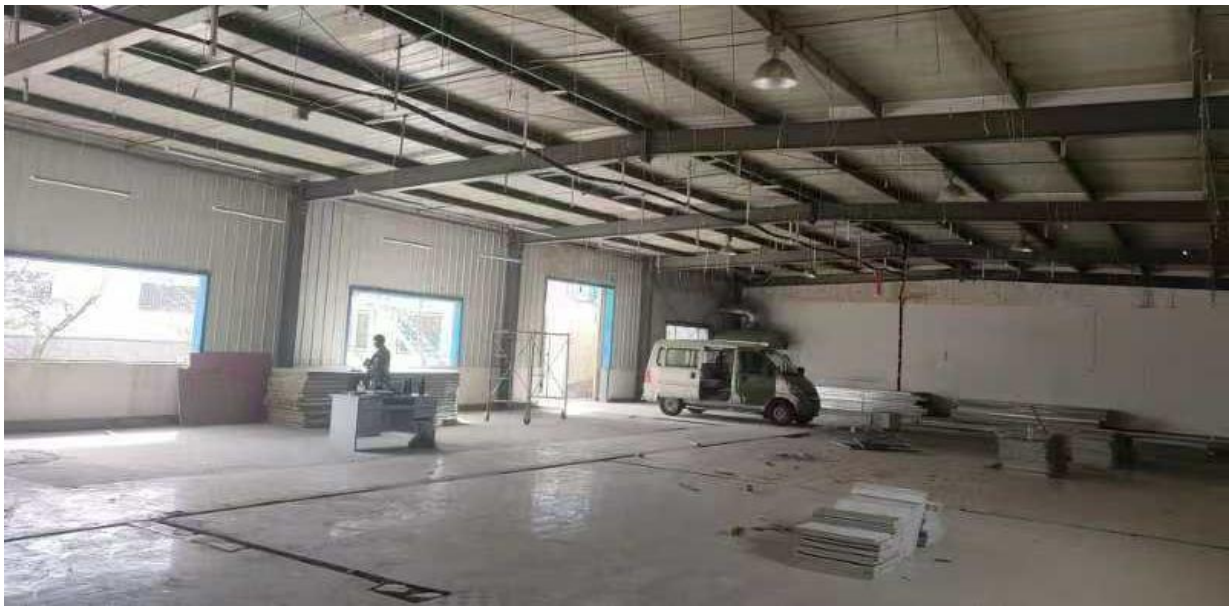
图1-6 本项目厂房内部现状
