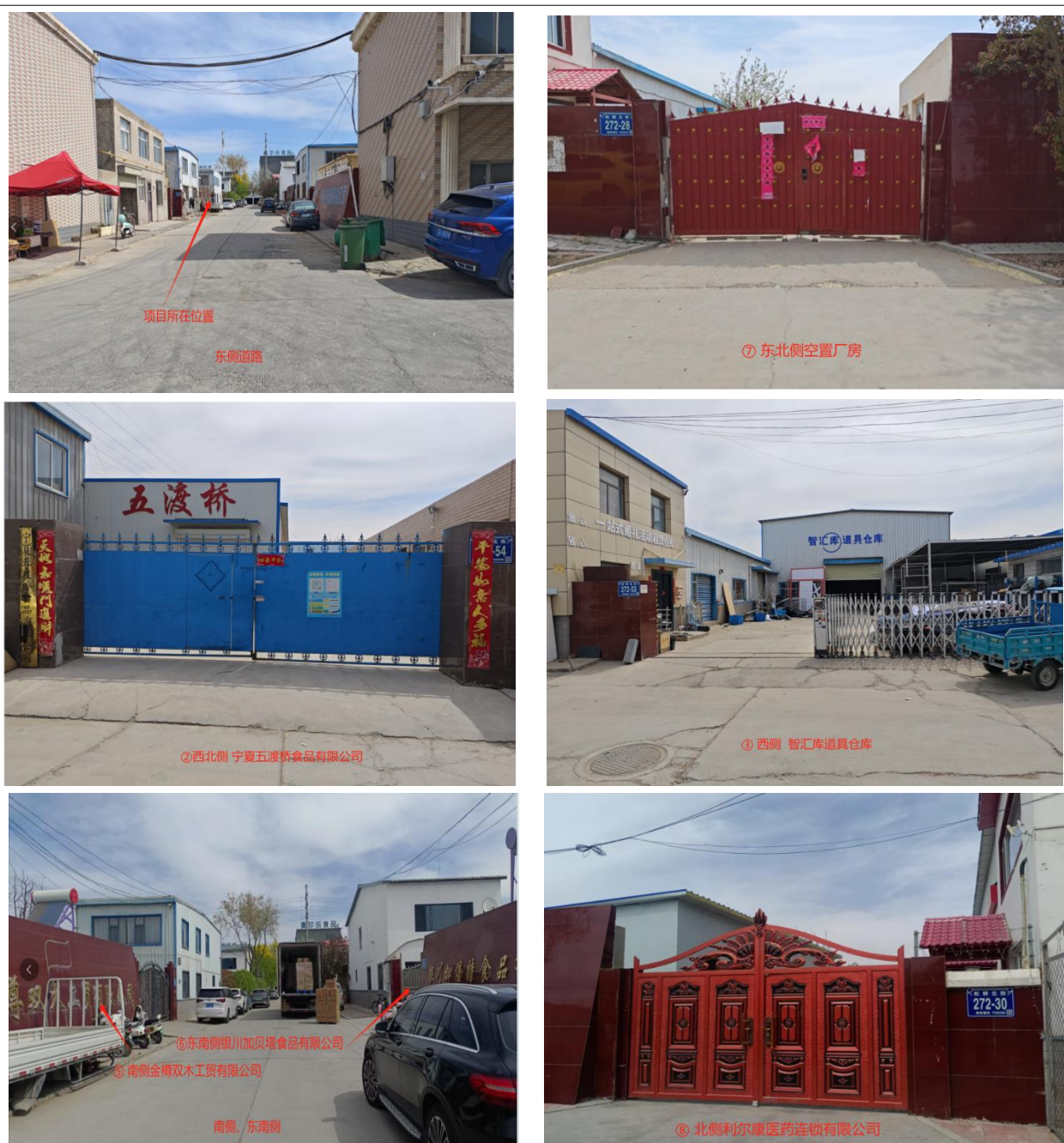
图1-3 本项目周围厂房现状
