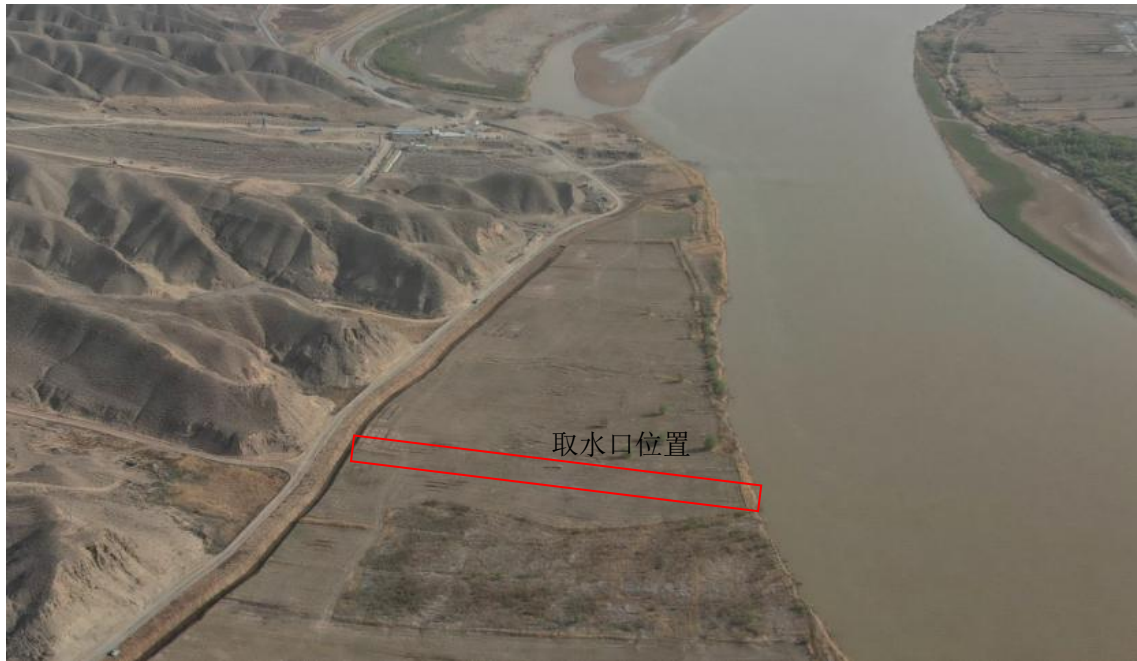
图 4.5.4-2 取水口位置航拍图
