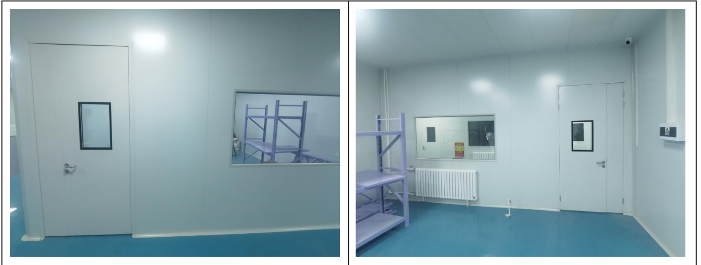
图 1-4 设备间现状照片
