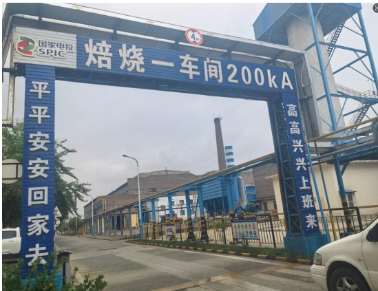
200kA 焙烧一车间
