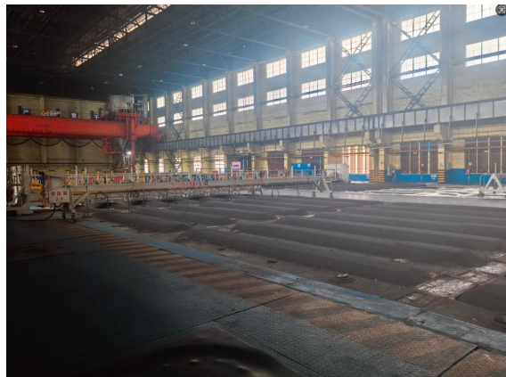
焙烧车间内部
