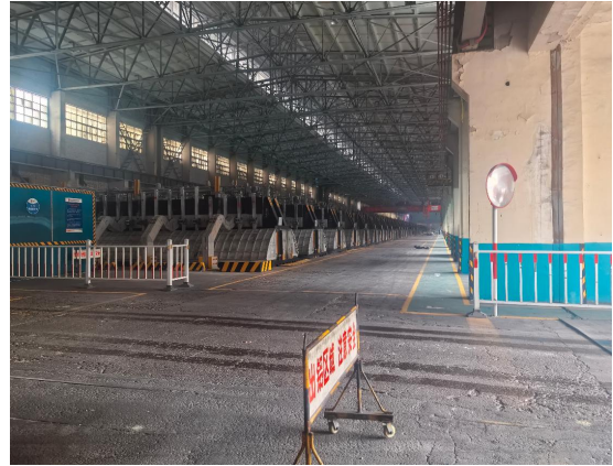
350kA 电解车间内部
