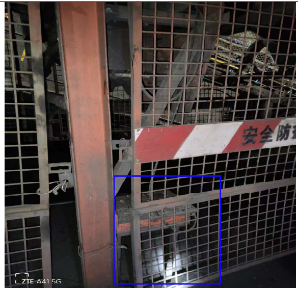
11 采区运输下山 X 射线机安装位置（设置 1.5m 高防护网）
