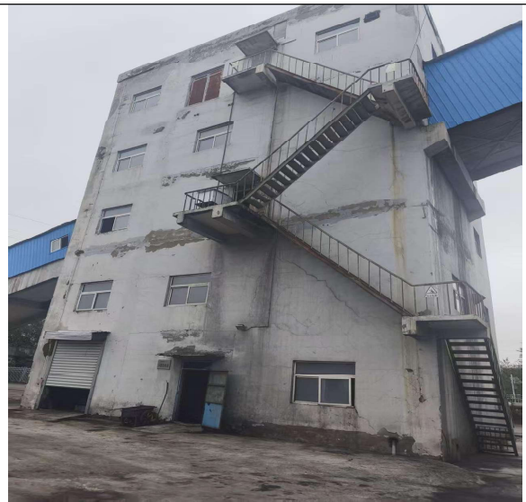
运煤隧道驱动机房西北侧窗户（共三层）
