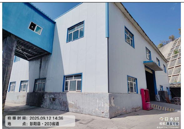
主井井口房东南侧、西南侧窗户
