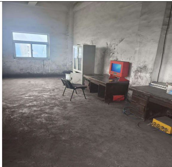
运煤隧道驱动机房内地面操作台（位于三楼）
