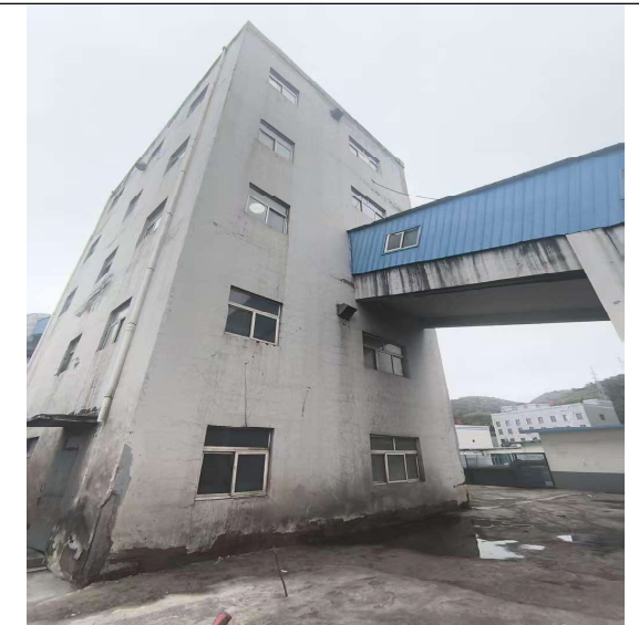
运煤隧道驱动机房西南侧、东南侧窗户（共三层）
