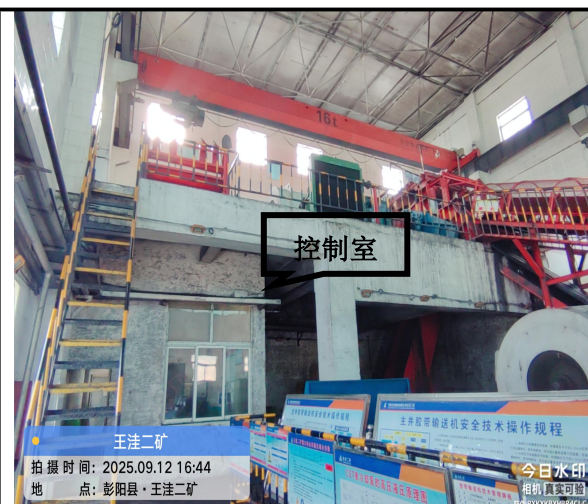
夹二层控制室及西侧窗户
