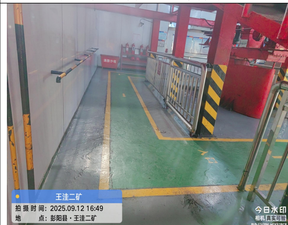
矿工上下井通道及 1.2m 防护栅栏
