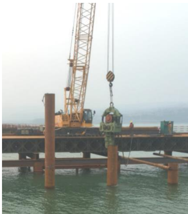
图 3.3-2 钢管桩施工示意图
