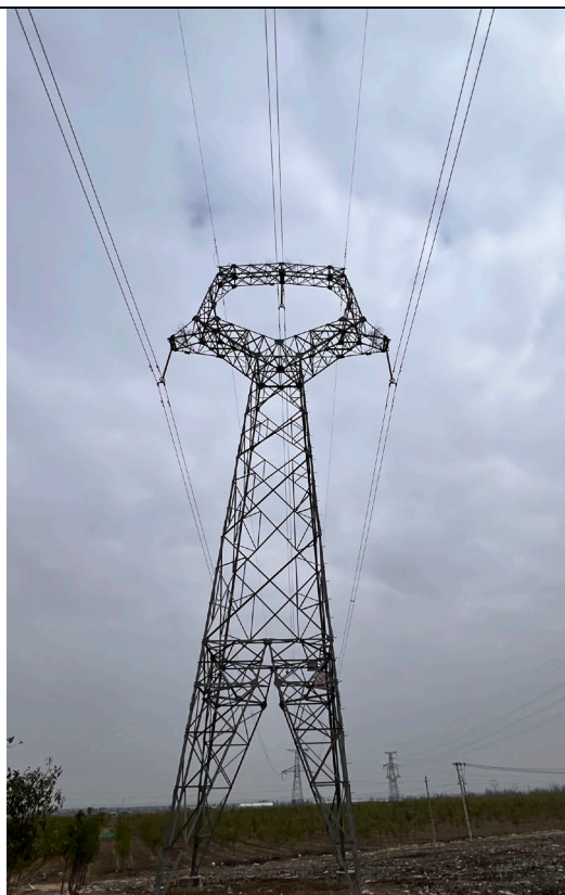
330kV 安彩 I 线 17#~18#段单回路塔
