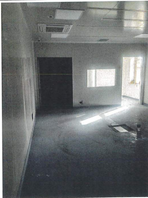
机房现状（机房东侧）
